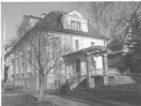
Nová budova Správy CHKO Slavkovský les
